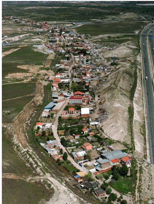
Vista aérea del sector 6 en la que se observa su estructura lineal, siguiendo la antigua Cañada Real Galiana Fuente: Vallecas.va
